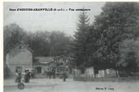
Gare d'ÉCOUEN-ÉZANVILLE (1877) - Vue extérieure
