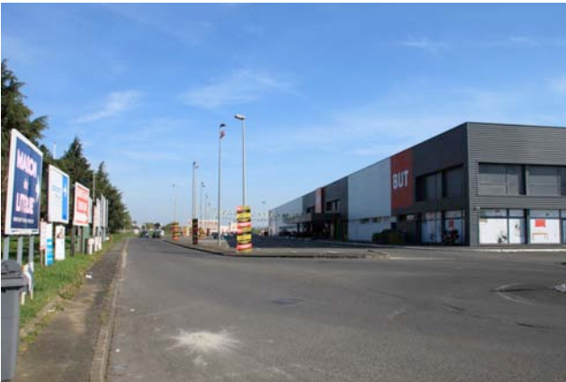
2 – Voie longitudinale Ouest longeant la RD 301
