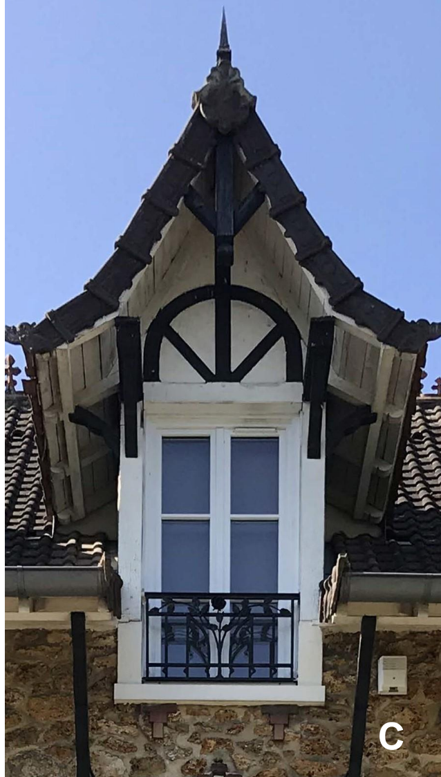
C Détail lucarne centrale à bâtière et coyaux D Détails travée centrale et ornementation de ferronnerie
