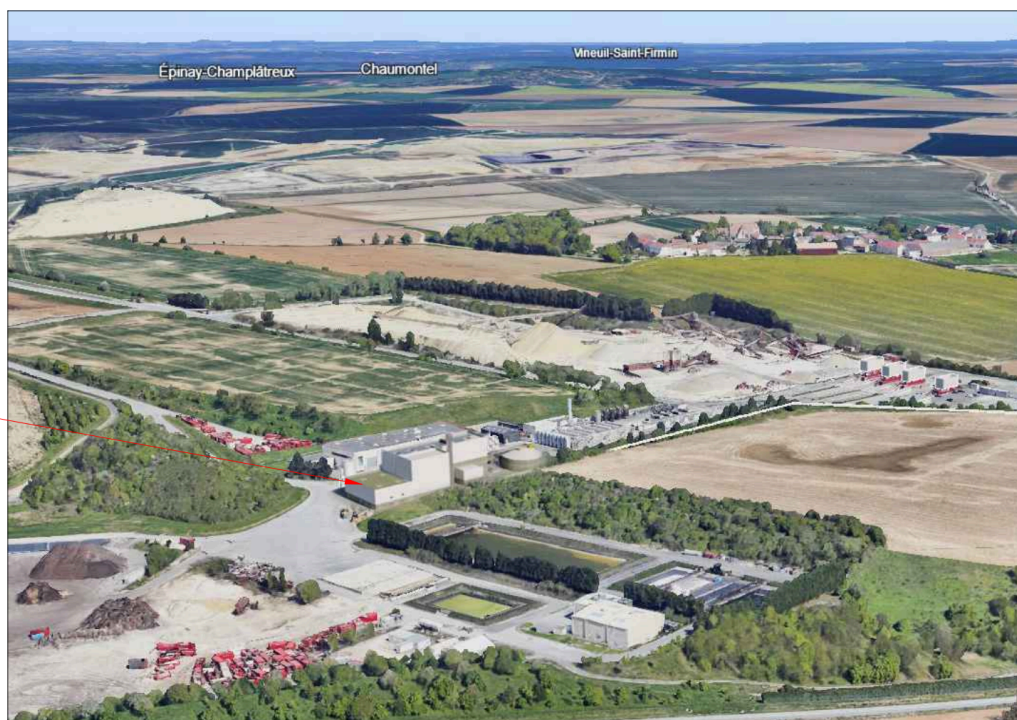
Figure 3 : Photomontage de mise en situation de la chaufferie CSR
